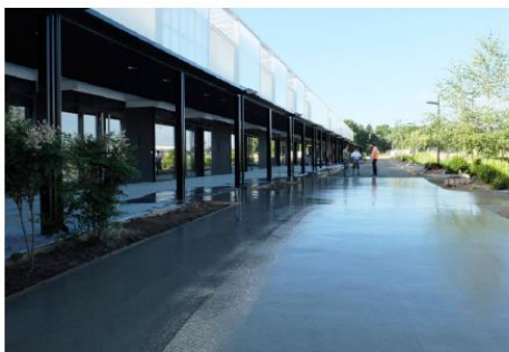
Le regroupement de l'ensemble des baies de la façade principale sous forme d'un bandeau prolongeant l'ensemble des rues dédiées à la circulation piétonne est une proposition simple qui a permis de conférer une très grande unité de traitement à l'ensemble des enseignes présentes sur le site (Chinon - 37).
