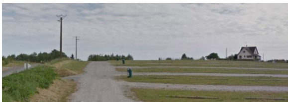
Exemple de mobilisation de revêtements perméables et semi-perméable au sol, parking n°6 du ZooParc
