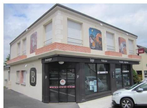
Alignement de devanture commerciale à la hauteur du premier niveau, Saint-Romain-sur-Cher
