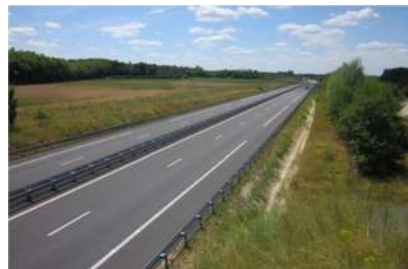
Autoroute à Méhers
