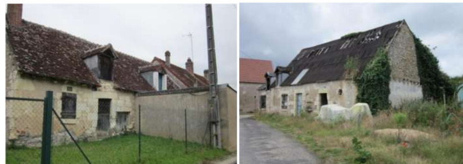
Bâti rural traditionnel à potentiel de réhabilitation et de mise en valeur. L'autorisation du changement de destination est une opportunité (Hameau de Gaudrie à Chatillon et des Bas-Bonneaux à Mareuil)
